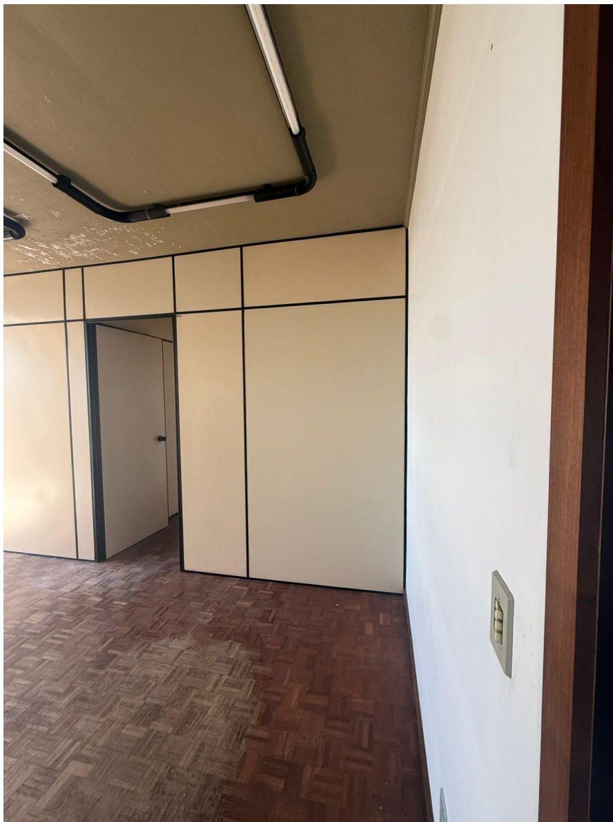
Foto 12: Sala 42 interna Fonte: Carvalho Lira Engenharia, 2026
