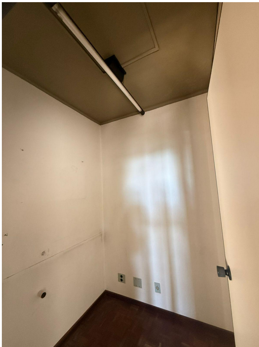
Foto 11: Sala 42 interna Fonte: Carvalho Lira Engenharia, 2026
